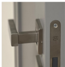
WIDOCZNY BRAK FELCA
